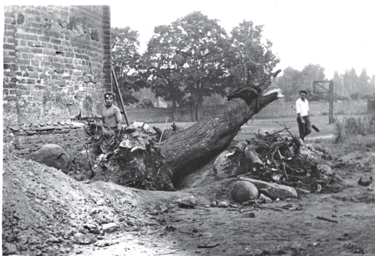
2 pav. Tvirtinami pamatai ties presbiterija bažnyčios Š pusėje. 1965 m. rugsėjis. P. Basčio nuotr.
